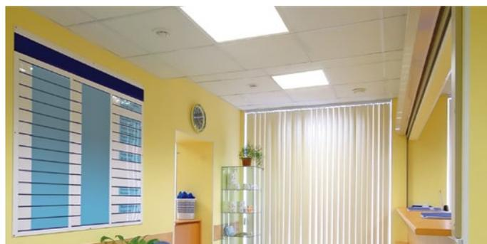
Светильники встраиваются в подвесные потолки типа «Армстронг», могут монтироваться накладным способом на поверхность потолка.
